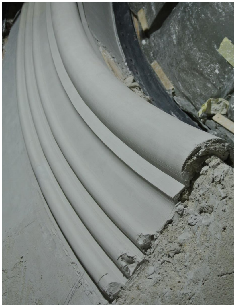
Profilatura pe contur curb realizata cu ajutorul sablonului (Fig. 10)
