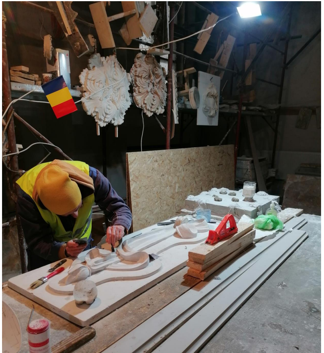
Reparatii realizate dupa extragerea elementului din matrita (Fig. 14)
