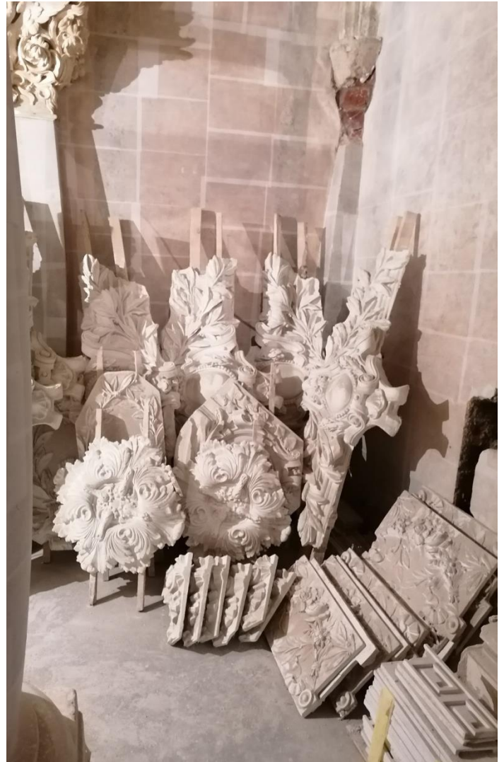
Elemente decorative realizate prin turnare in matrite (Fig. 12, 13)
