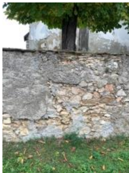
Obr. č. 13 & 14: Poruchy múru: chýbajúca strieška proti zrážkam, opadaná nevhodná cementová omietka odhaľujúca pôvodné murivo, ktoré je bez ochrany. Zdroj: ProMonumenta
