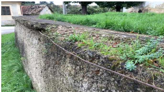
Obr. č. 13 & 14: Poruchy múru: chýbajúca strieška proti zrážkam, opadaná nevhodná cementová omietka odhaľujúca pôvodné murivo, ktoré je bez ochrany. Zdroj: ProMonumenta
